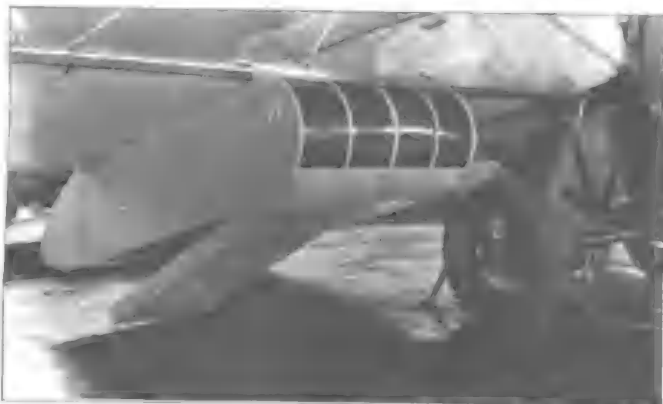
Ранний вариант кассеты Г-61 для подъема четырех человек на самолете Р-5.
